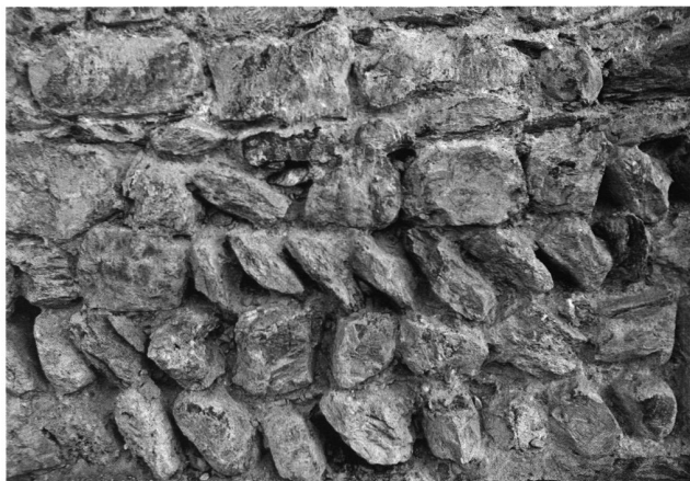
13: Palas Südfassade, Mauerwerk 1.
