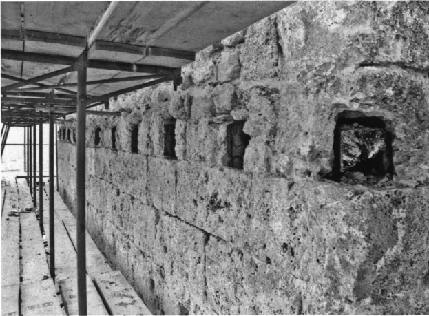
7: Bergfried Nordseite, Tuffquadermauerwerk II a und abgesägte Kragbalken der ehemaligen Wehrlaube.
