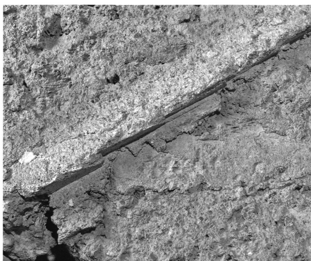
11a: Ausschnitt aus Abb. 11. Mörtelkragen des Taschendaches mit Negativen der Schindeldeckung.
