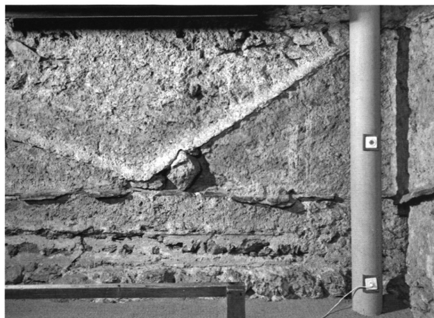
11: Bergfried 5. OG Ostmauer. Von unten nach oben: Negativ der Satteldach-Traufpfette. An seinem oberen Rand Abdrücke der Schindeldeckung, 25–30 cm weiter oben horizontaler Wasserschlag aus Melslerplatten. Auch am hellen Mörtelkragen des Taschendaches zeichnen sich Schindelnegative ab.
