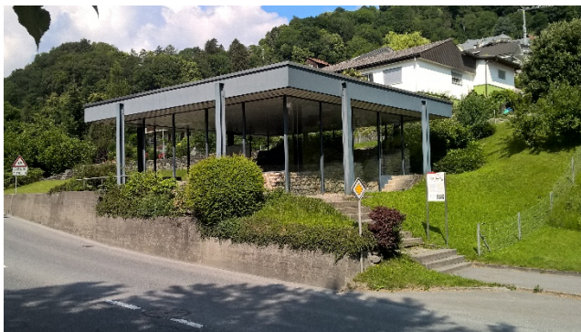
Schutzbau über dem besterhaltenen Teil der Römischen Villa Sargans (hier konserviert seit 1969)
