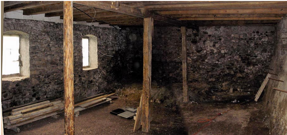
Abb. 5: Blick in den Torkelraum mit Abstützung der Diele vor dem Umbau.
