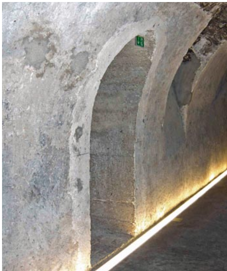
Abb. 7: Grosses Gewölbe mit neu gegossenem Boden und im Boden integrierter Beleuchtung.
