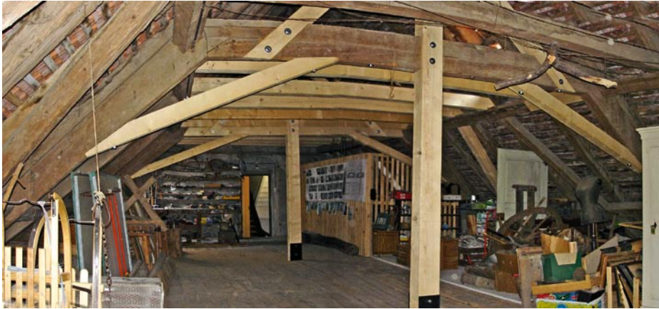
Abb. 4: Rekonstruktion des Dachstuhls in der über dem Torkelraum gelegenen Diele.
