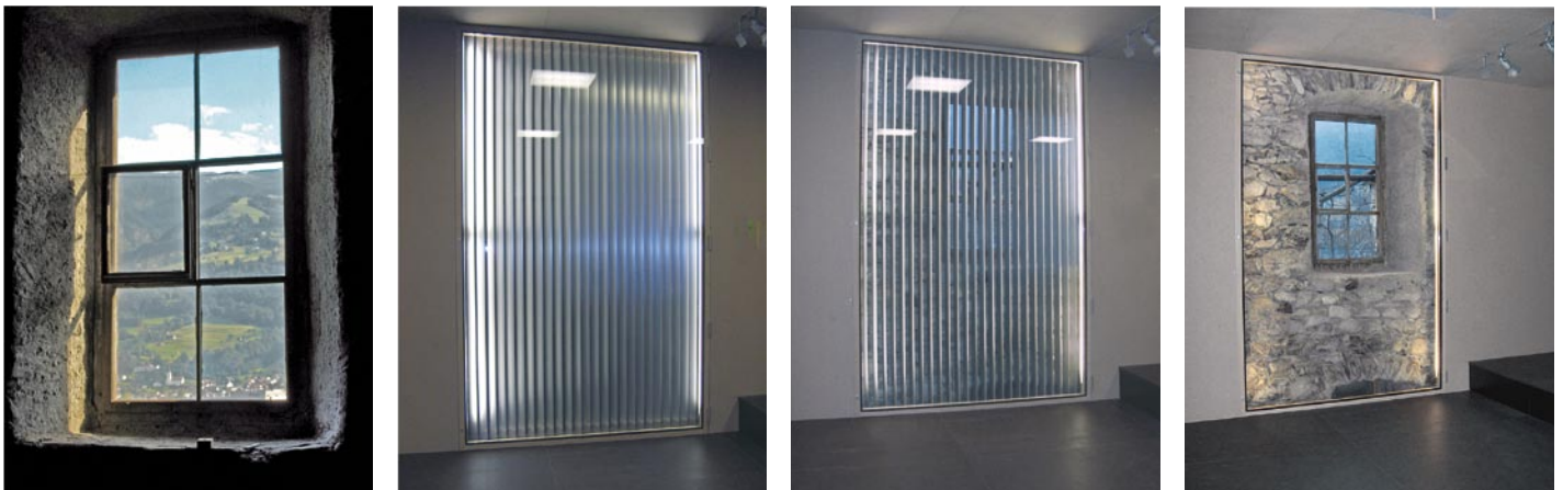
Abb. 6: Südfenster: links vor dem Umbau, rechts mit den Jalousien und der Rahmenbeleuchtung, die die Südmauer einsehen lassen.
