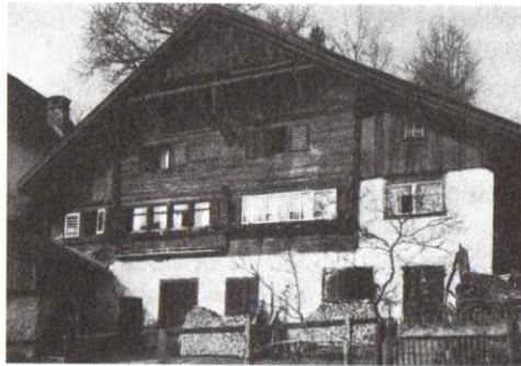
Die sog. «Färbi» in der Sarganser Farb, zwischen dem Schwefelbad und Vild. Der Gewerbebetrieb ist seit 1549 belegt und wurde im 18. Jahrhundert aufgegeben. Das Haus verrät in seinem Äusseren die einstige Zweckbestimmung: unter einem breiten Vordach sind Holzstangen zum Aufhängen der gefärbten Tücher vorhanden. Es brannte am 9. Dezember 1969 nieder.
